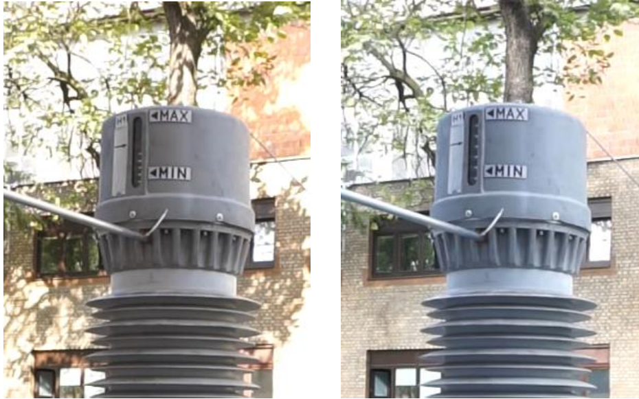
Slika 29. Položaj membrane: lijevo - početni, desno - maksimalni
