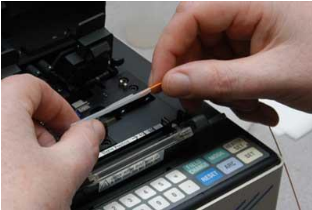
Slika 3.7. Spajanje optičkog kabela postupkom zavarivanja [2]
