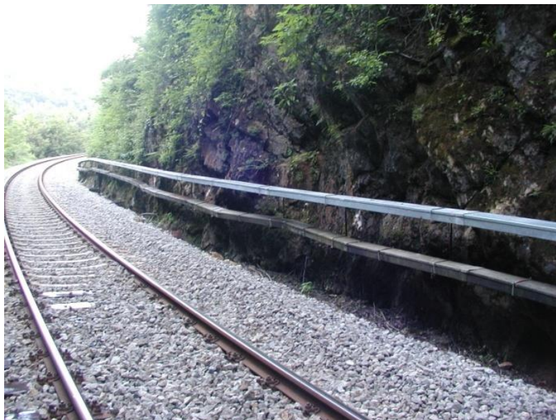
Slika 3.4. Vođenje kabela u usjecima i prosecima
