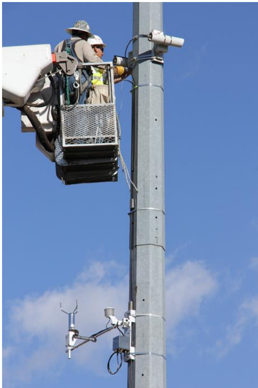
Slika 2.16 Montaža kamere za snimanje provjesa i procesuiranje slike te pripadajuće meteorološke i komunikacijske opreme
