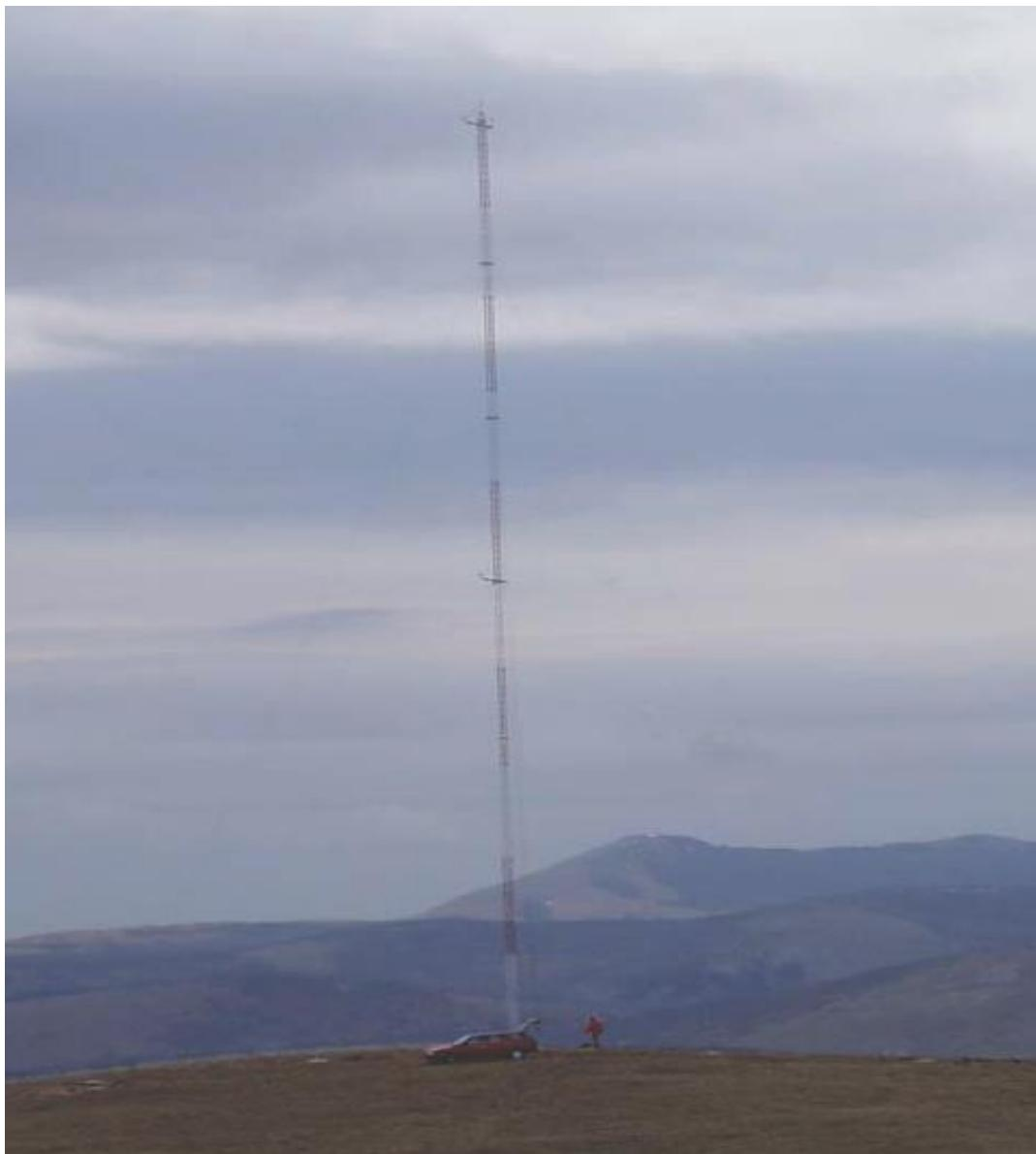
**Slika 2.10 Mjerni stup tip Dalekovod visine 50 m**
