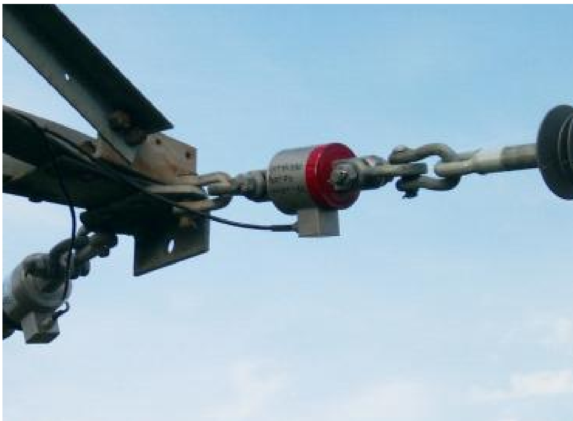
Slika 2.20 Montaža sustava za mjerenje naprezanja vodiča nadzemnog dalekovoda te pripadajuće ovjesne i spojne opreme
