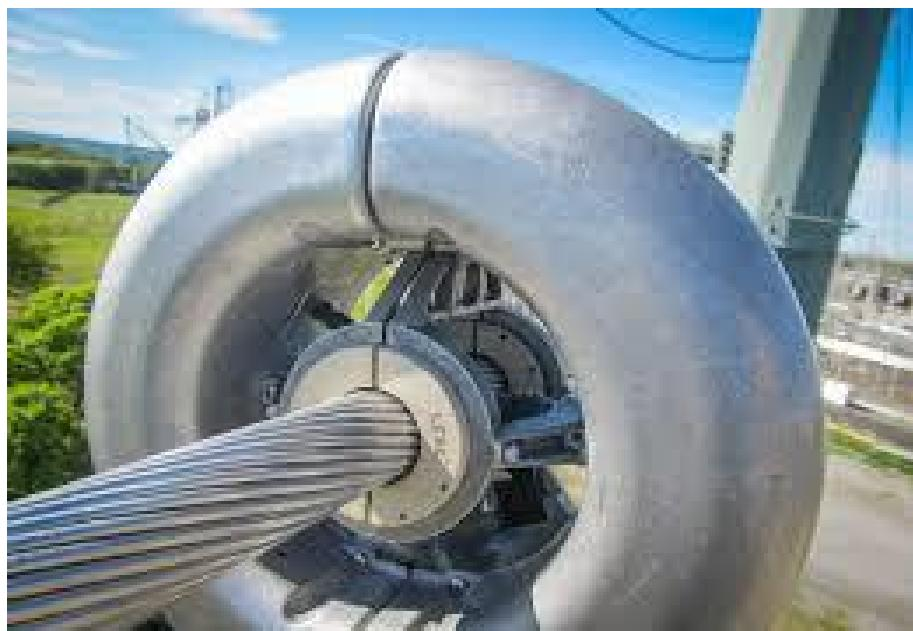
**Slika 2.14 Prikaz tipičnog uređaja za mjerjenje temperature vodiča (tzv. Power Donut)**
