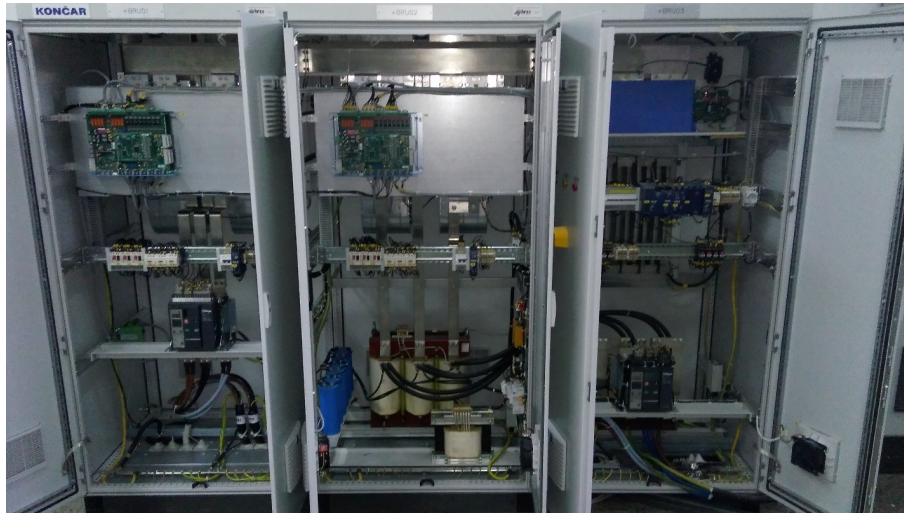
Slika 3.2: AC-DC-AC pretvarač
