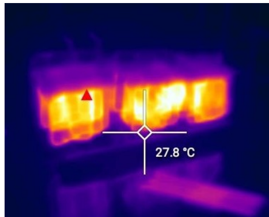
Slika 6.9: Termografna snimka otpornika za vrijeme mjerenja
