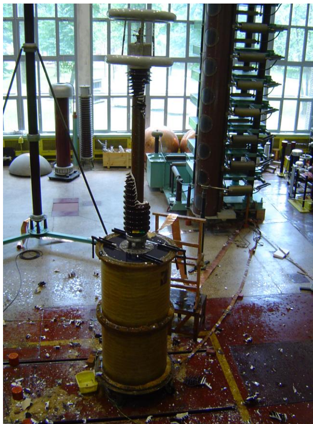
Slika 4.6 – Rasprsnuće porculanskog izolatora transformatorskog provodnika
