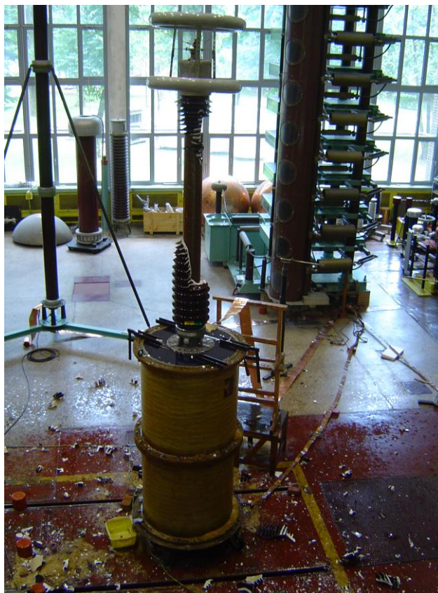
Slika 4.6 – Rasprsnuće porculanskog izolatora transformatorskog provodnika
