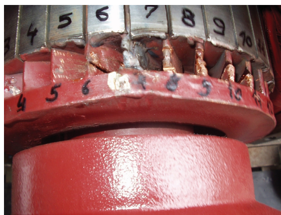
Slika G.5. Razina IV oštećenja kaveza rotora
