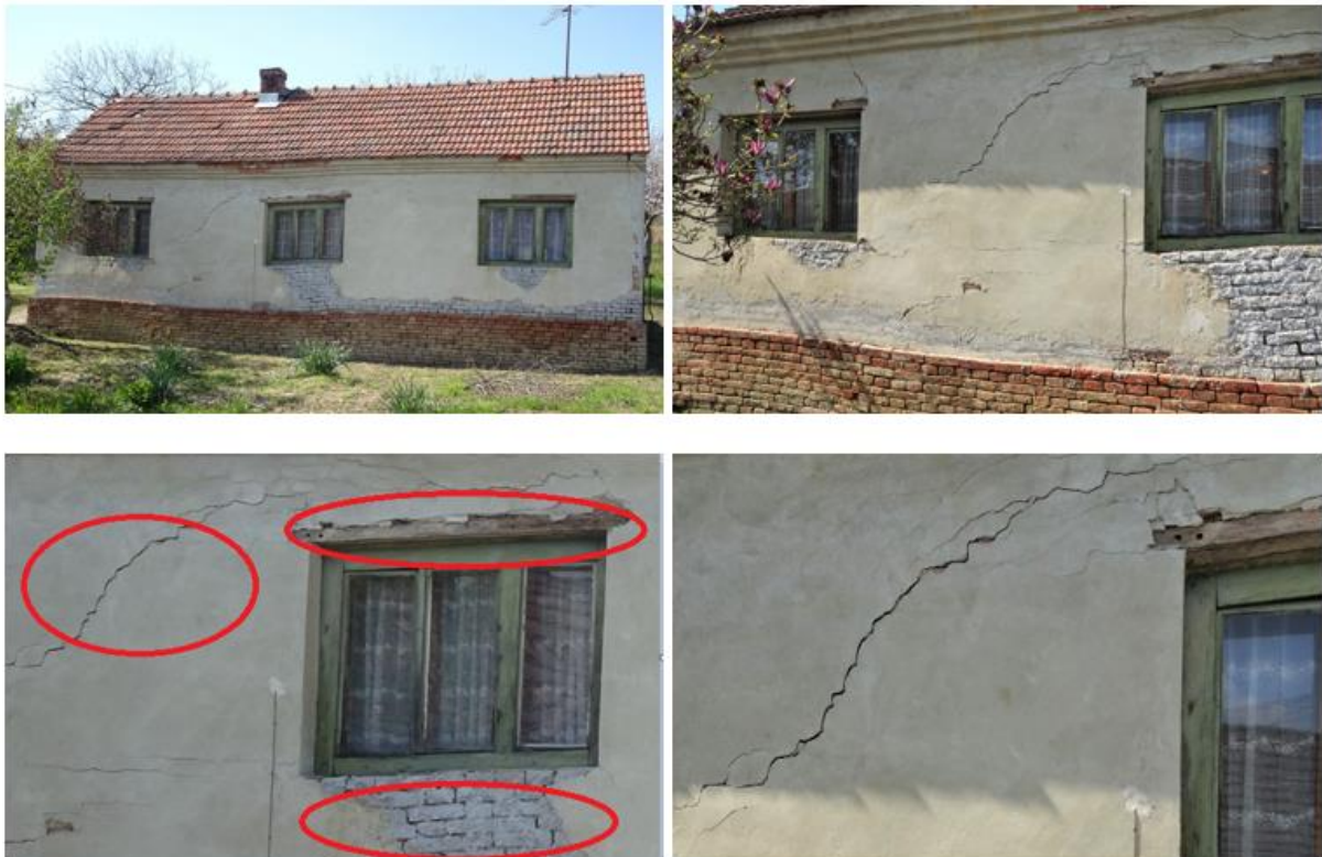
Slika 2.9. Fotoelaborat prijavljenih oštećenja nastalih od potresa Izvor: osiguratelj iz RH
