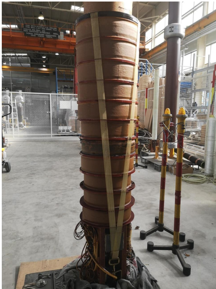
Slika 34. Aktivni dio transformatora nakon ispitivanja
