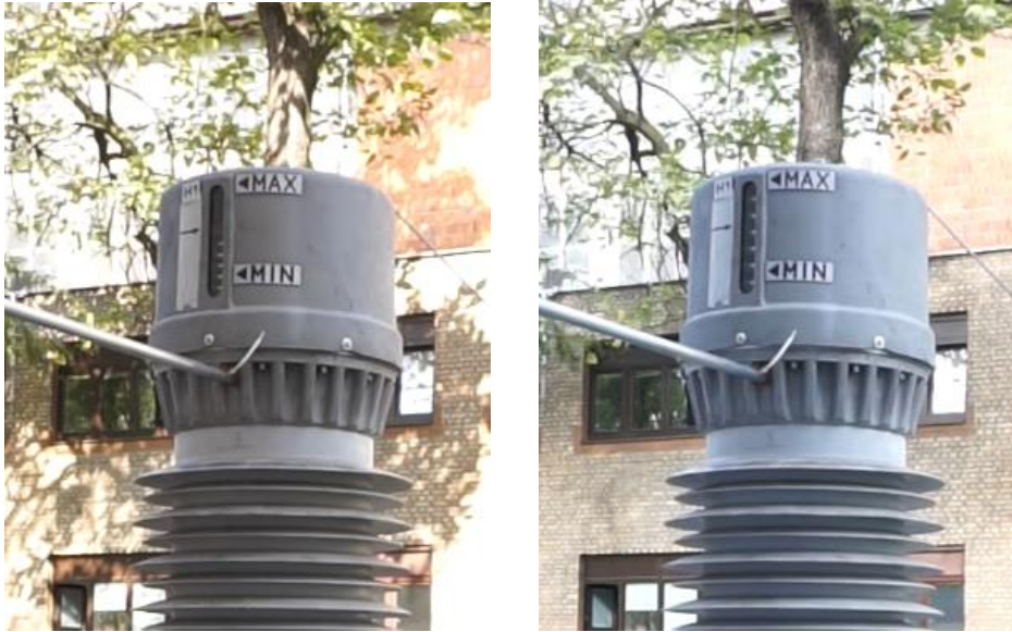
Slika 29. Položaj membrane: lijevo - početni, desno - maksimalni
