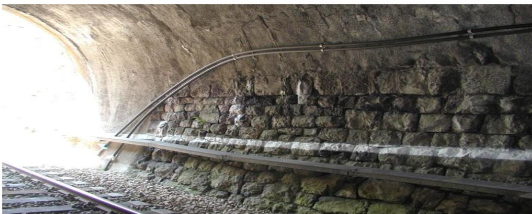
Slika 3.6. Princip vođenja kabela i PEHD cijevi unutar tunela
