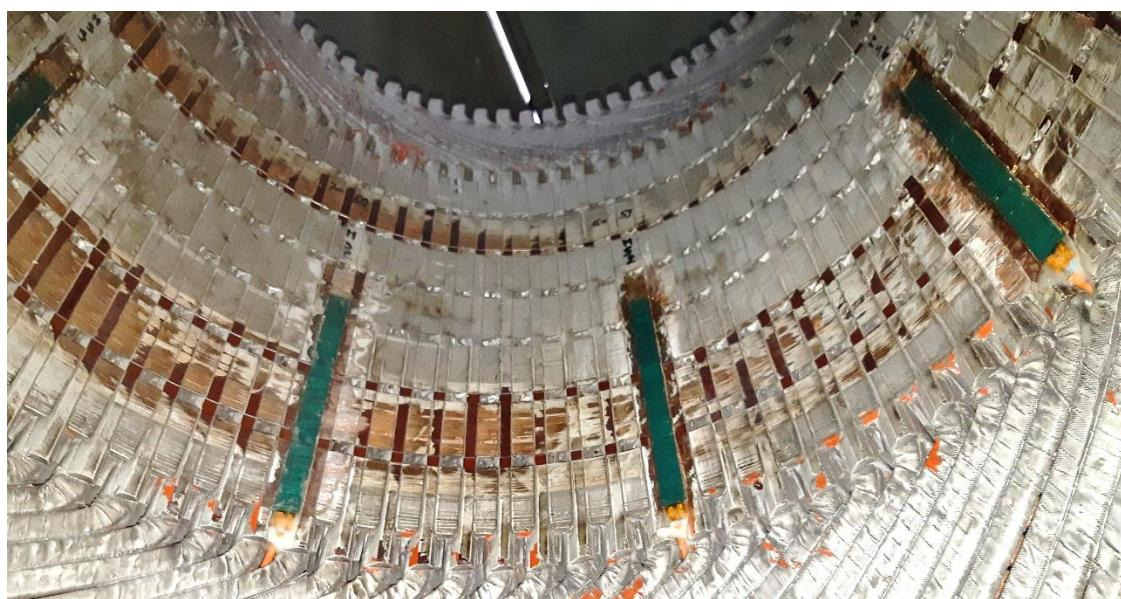
Slika 6.2 Mjerni svitci ugrađeni na zube generatora
