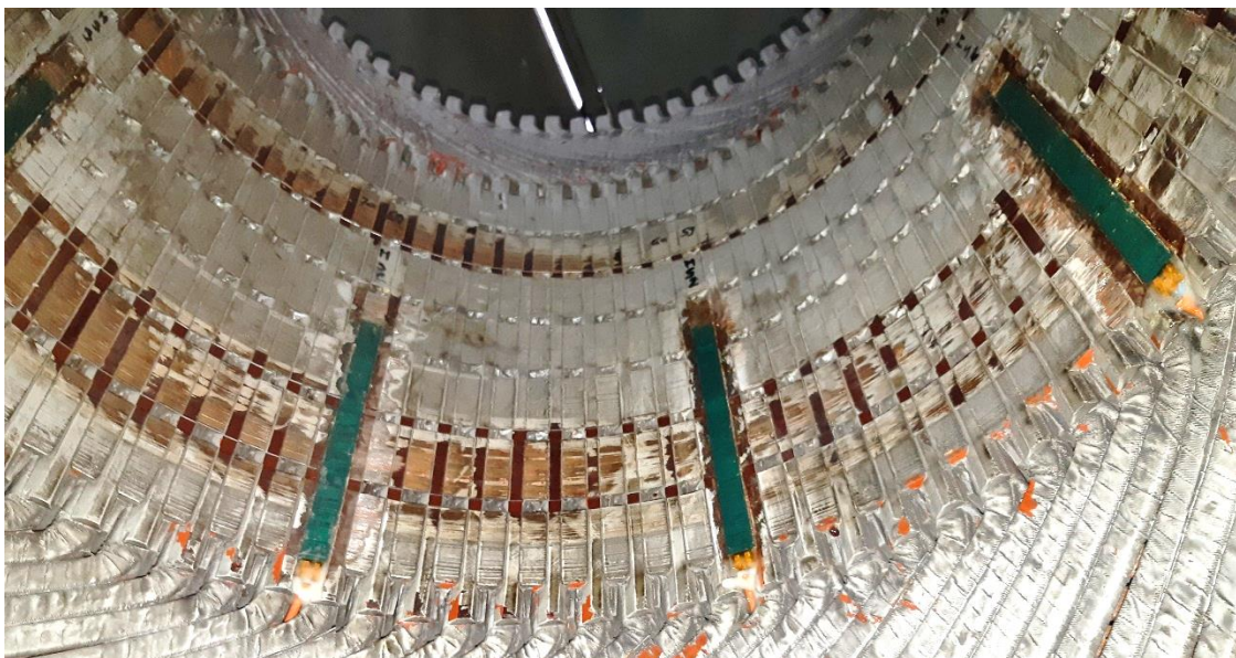
Slika 6.2 Mjerni svitci ugrađeni na zube generatora
