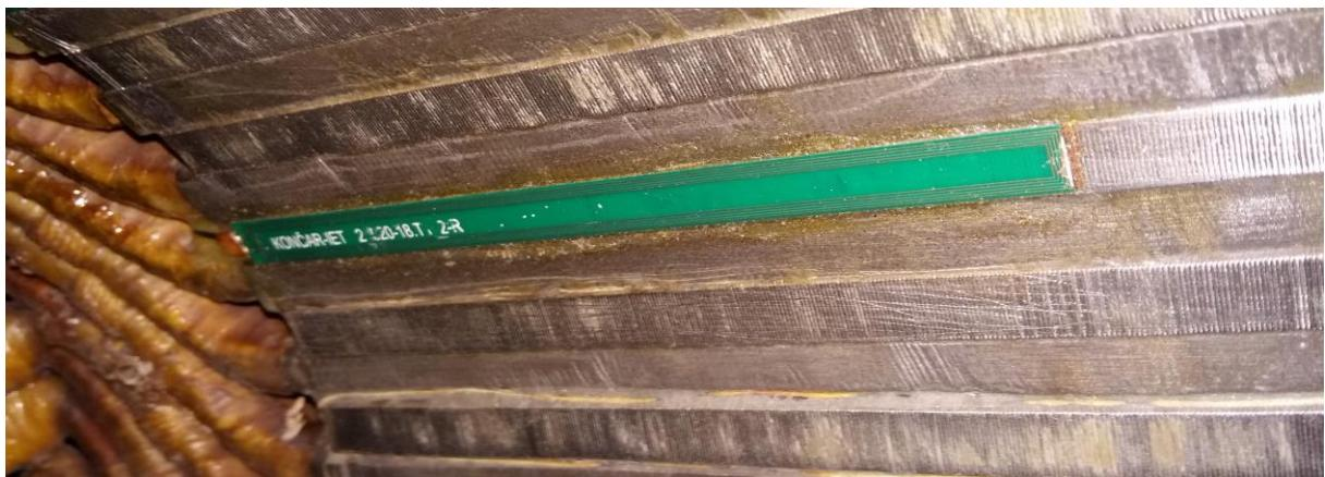
Slika 3.10 Mjerni svitak ugrađen na Zub statora
