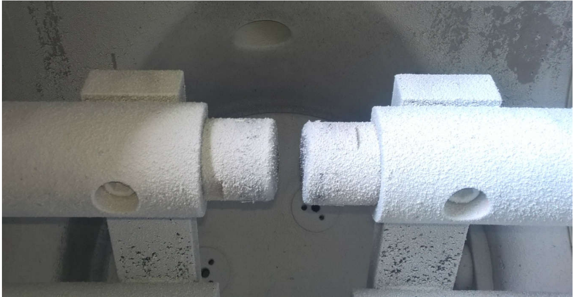
Slika 5.2.12. Izgled elektroda i lučnog prostora nakon jednopolnog lučnog kvara
