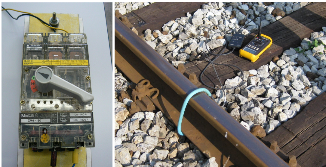
Slika 3.11. Sklopka za uklop i isklop strujnog kruga i svitak Rogovski za mjerenje struje povratnog voda
