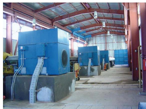
Slika A.2. „Ex e II T3“ motor, 6 kV, 1,9 MW
