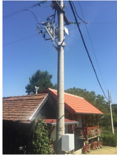
**Slika 8.10:** Vakuumski prekidač i upravljački ormari
