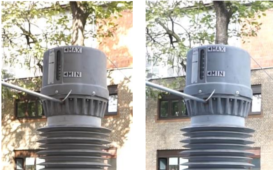
Slika 29. Položaj membrane: lijevo - početni, desno - maksimalni
