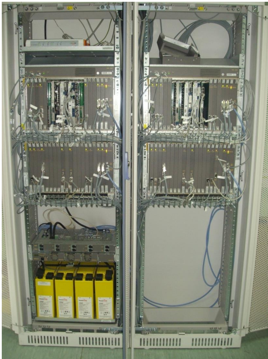
Slika 6.6. Funkcionalna centrala sa dva LIM-a
