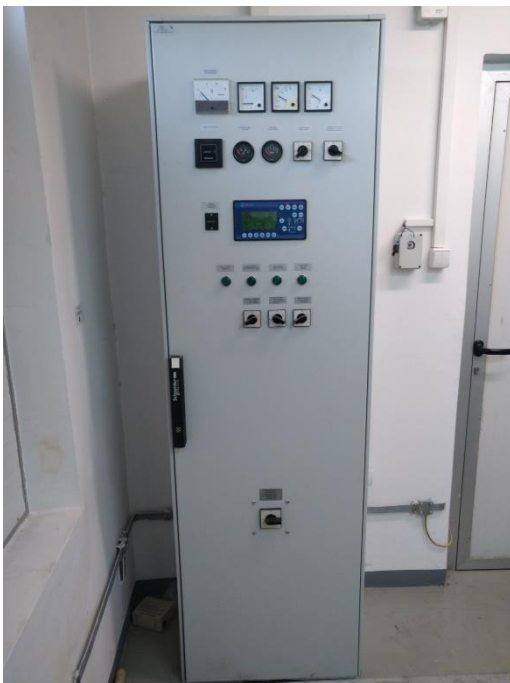
Slika 24. Upravljački ormar automatike diesel agregata
