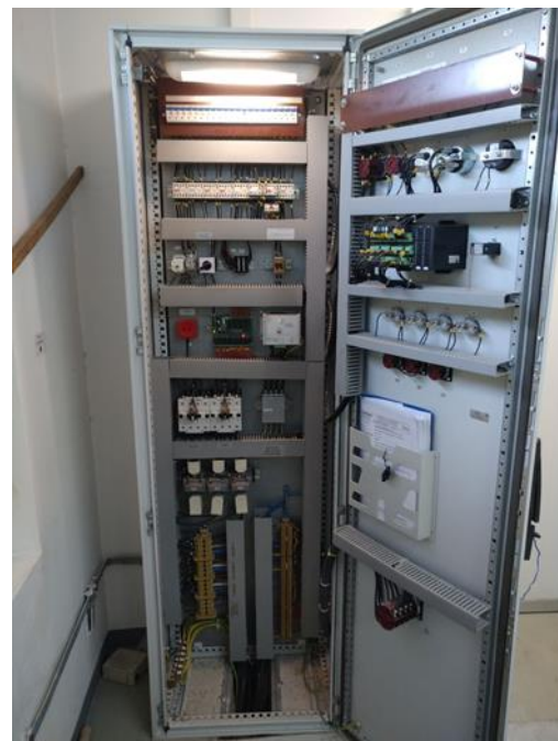
Slika 24. Upravljački ormar automatike diesel agregata
