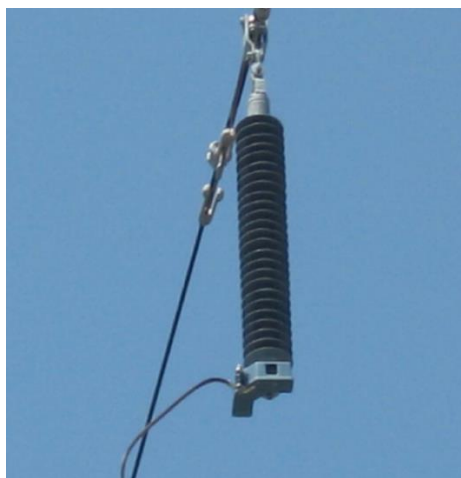
Slika 4.10: Brojač prorada odvodnika prenapona
