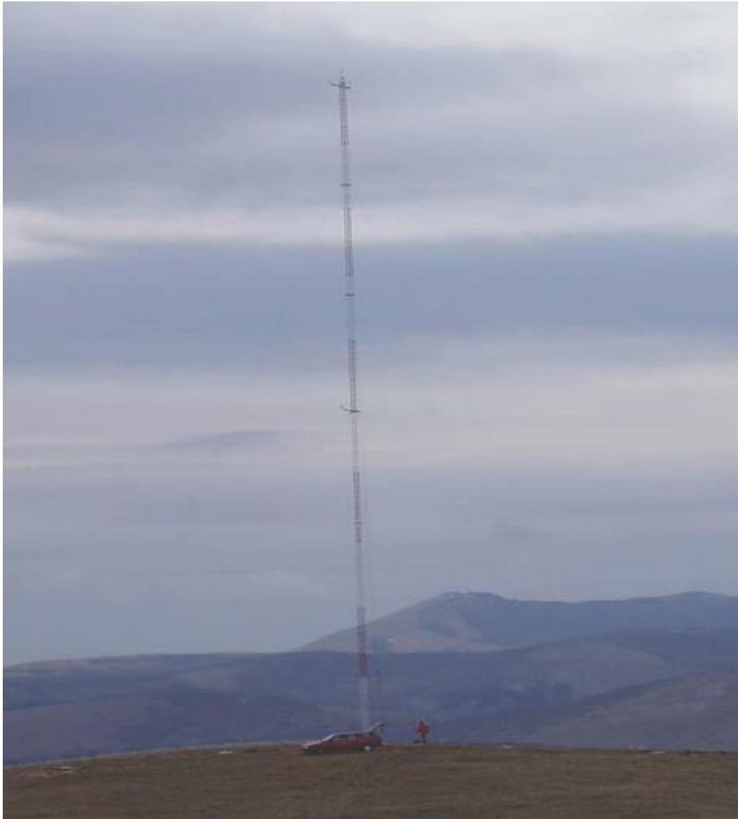
Slika 2.10 Mjerni stup tip Dalekovod visine 50 m
