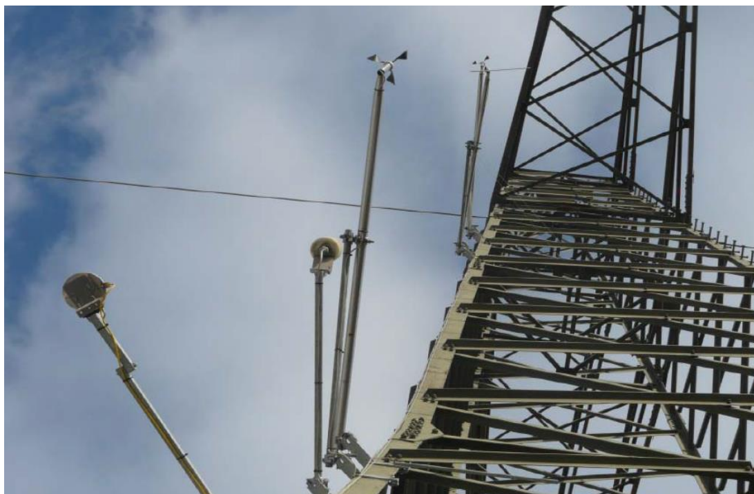
Slika 2.13 Primjer meteorološke mjerne garniture na nadzemnim dalekovodima
