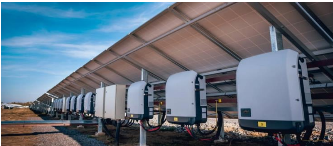
Sl. 1.2 Primjer montaže izmjenjivača uz profilne nosače konstrukcije [8]
